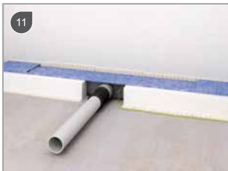
Podłączenie rury kanalizacyjnej \varnothing 40\text{mm}
