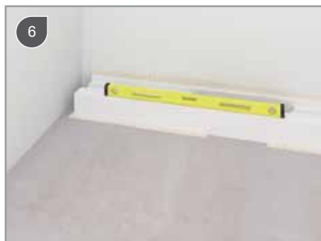
Poziome pozycjonowanie bloczka instalacyjnego z polistyrenu
