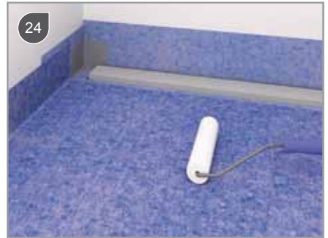
Instalacja wodoodpornej maty - przy pomocy wałka dobrze docisnąć aby przylegała
