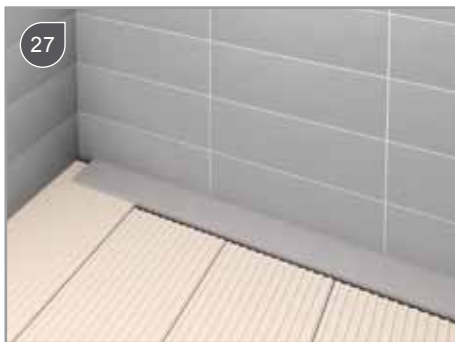
Rozprowadzenie kleju (EN 12004 C2)
