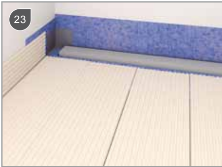
Rozprowadzenie kleju (EN 12004 C2)
