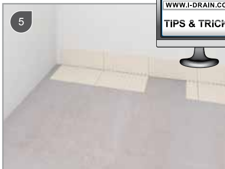
Rozprowadzenie kleju (EN 12004 C2)
