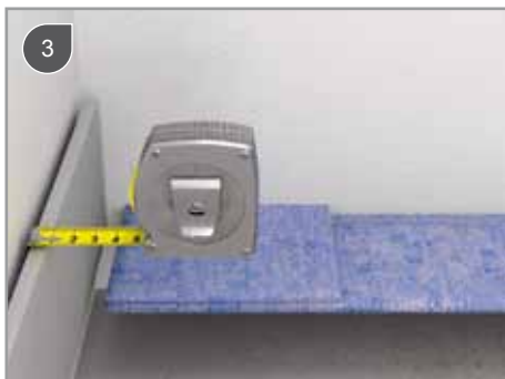
Pomiar grubości płytek *
