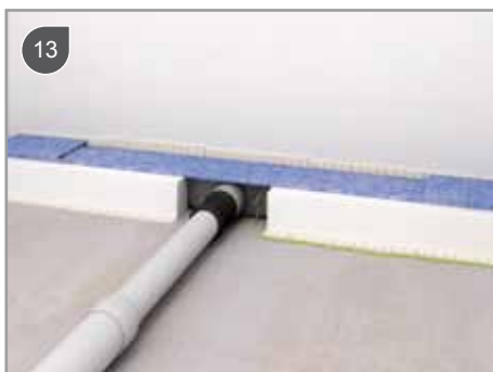
Podłączenie rury kanalizacyjnej Ø50mm
