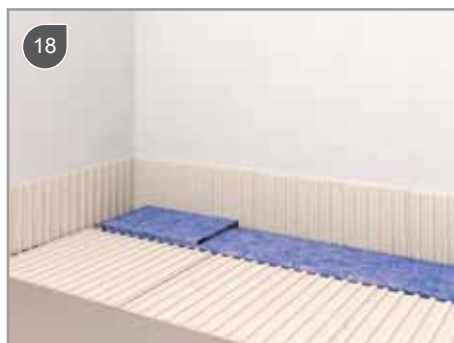
Rozprowadzenie kleju (EN 12004 C2): 20cm dookoła odwodnienia
