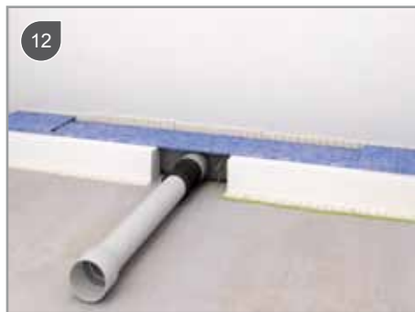
Zwiększenie średnicy rury kanalizacyjnej z \varnothing 40\text{mm} na \varnothing 50\text{mm} do 1m (max.) lub przed łukiem
