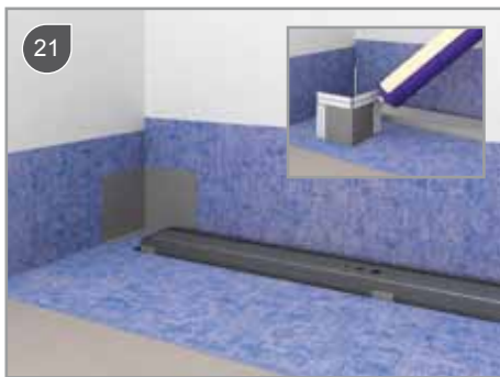
Pozycjonowanie plastikowego profilu (lewy i prawy)
