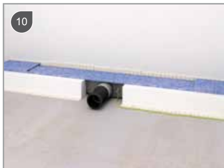
Podłączenie odpływu
