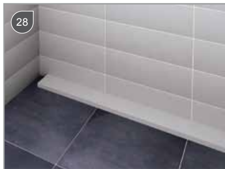
Mocowanie płytek podłogowych
