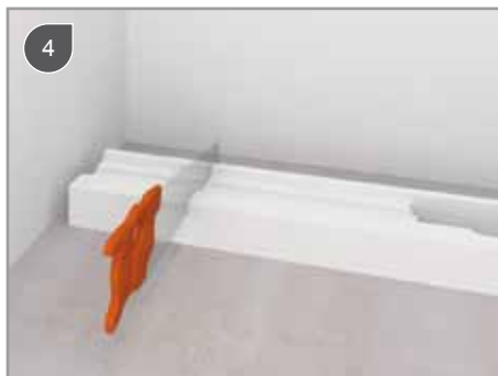
W razie potrzeby dociąć bloczek z polistyrenu dożądanego wymiaru
